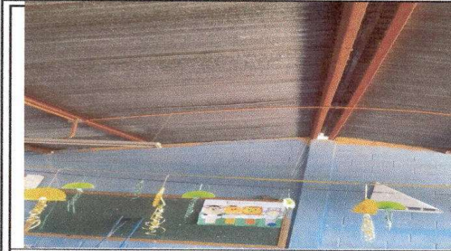
Foto1: Sustitución de lámina troquelada aluzinc calibre 26
