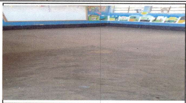
Foto 2: Sustitución de piso de cemento a piso granito
